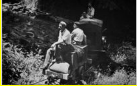
Foto risalente agli anni 50: operai a bordo di un convoglio attraverso la Foresta Umbra. E' visibile il locomotore diesel da 20 Hp, un Montania L2-Foto archivio storico UTB umbra- tratta da "la ferrovia decauville nella Foresta Umbra, di Claudio Angeloro – Rivista Silavee n°4 anno 2)
